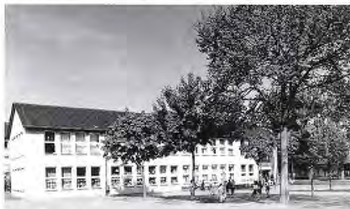
Erweiterungsbau der heutigen Martin-Luther-Schule.
